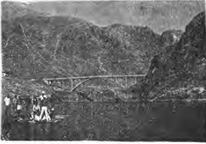
Foto 1 — İlk akarsu rasatlarının yapıldığı yer. Keban köprüsü ve baraj yeri, köprü baraj gövdesi içinde kalacağından yıkılmıştır. Tarihi Keban köprüsü ve kelek'le Fırat'a çıkış (Eylül, 1964).
