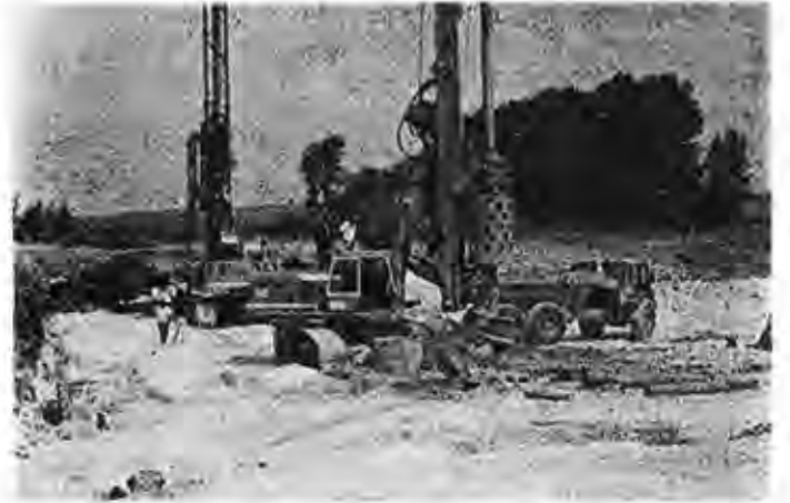
Foto 2 — Otoyol güzergâhındaki 124 üncü kilometrede köprülü geçiş için, temel kazıklarının inşaatı.
