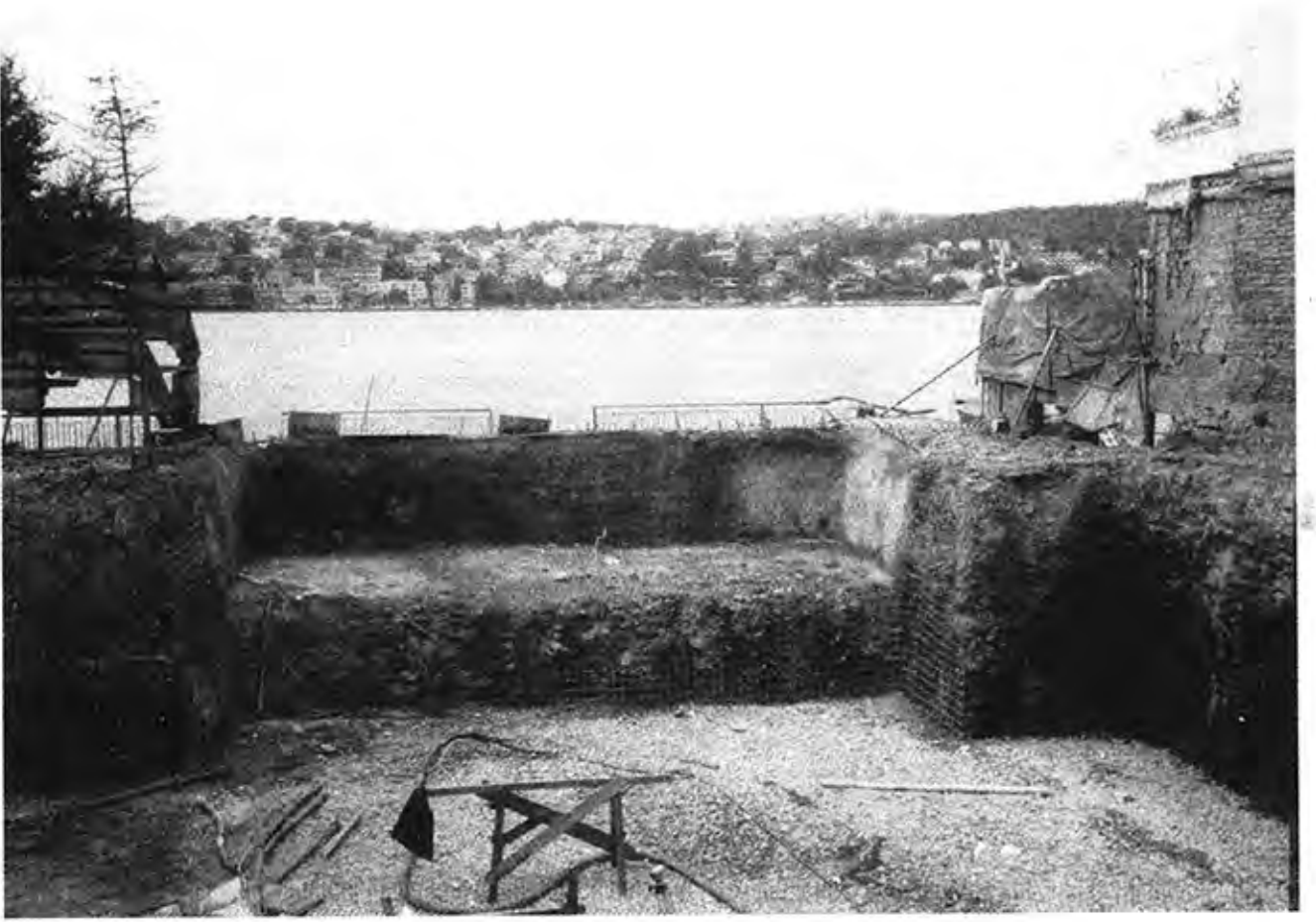
JET GROUT KOLON UYGULAMASI SONRASI Nuri Özaltın Yalısı - Kanlıca, İstanbul, 1999
