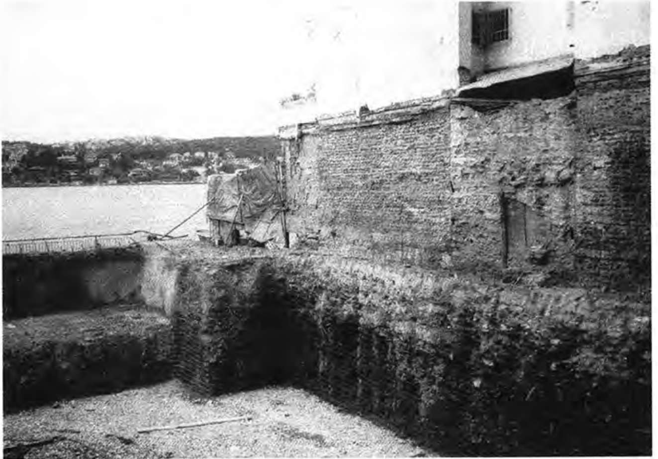
JET GROUT KOLON UYGULAMASI SONRASI Nuri Özaltın Yalısı - Kanlıca, İstanbul, 1999
