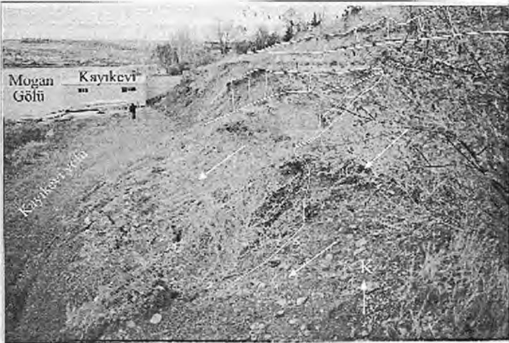
Şekil 9. S2 no.lu şev kaymasının görünümü.
