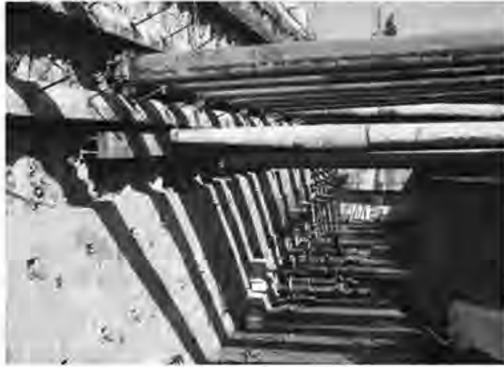
Şekil 11. Batı duvarındaki aşırı yerdeğiştirmeden sonra destekleme sistemine ilave edilen yatay elemanlar.
