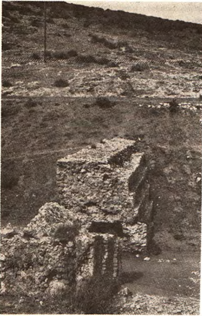
Şekil 5: Kağır Roma barajının bu günkü durumu (K.E. Şubat 1981).
