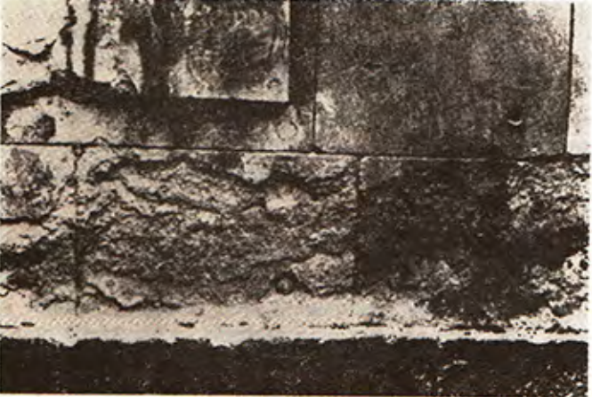
Şekil 6: Temelden kapilarite ile su yükselimi sonucu kabuk oluşumu (A. ARNOL'dan 1975).
