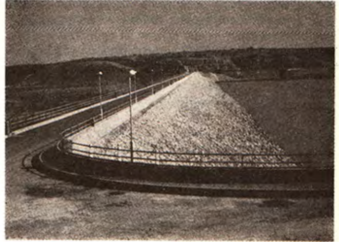
Şekil 7: Vadi Megenin (deliler vadisi)nde Megenin barajı, Yatay durumlu, çatlaklı Üst Kretase'ye ait kalker ve marnlı kalker ve marnlar üzerinde H. 39, V.
