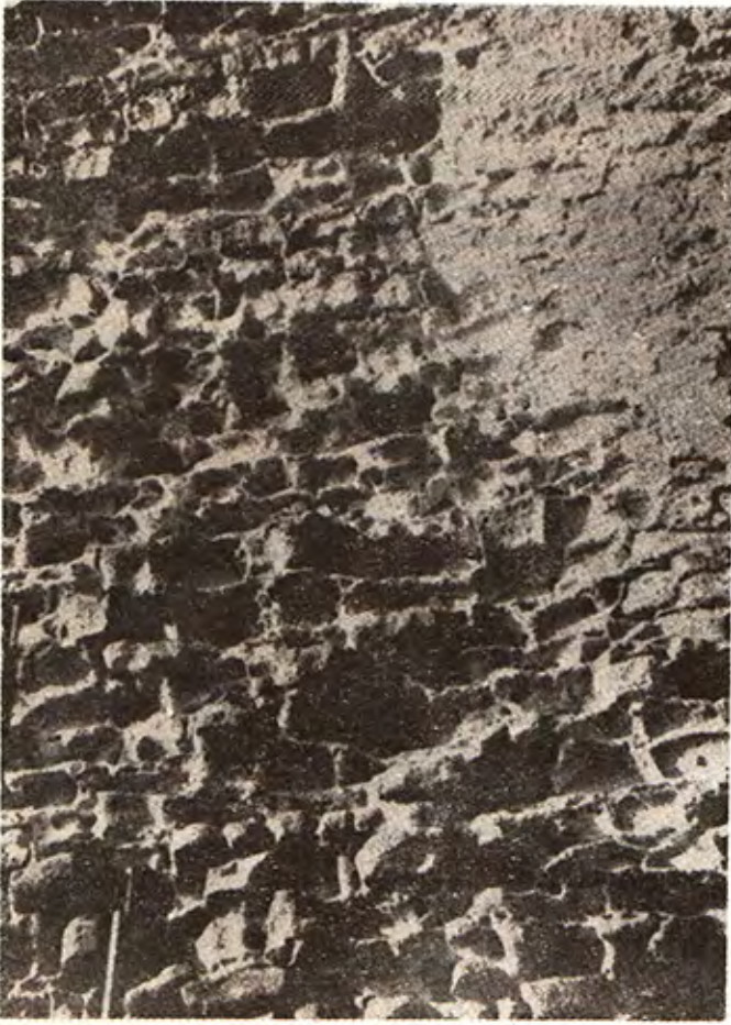
Şekil 5: Marnlı kalkerlerde gözlenen oyulmalar (R. MANARESSI'den 1976).
