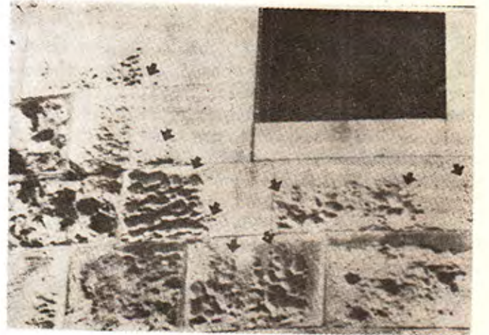
Şekil 4: Kalkerlerde denizel hareketler sonucu oluşan oyulmalar. (J.P. PAULY'dan 1976).
