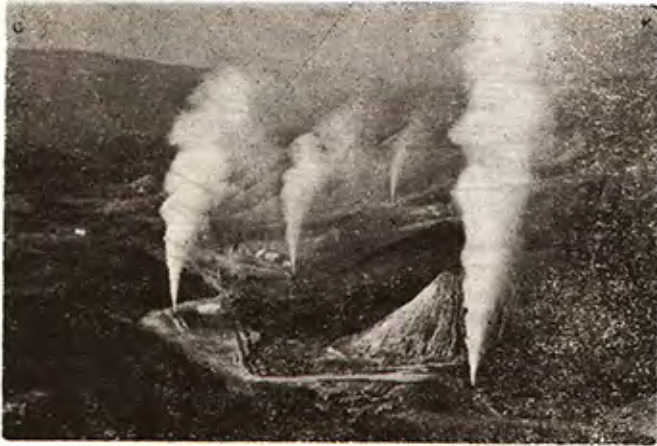
Foto 2 — Kızıldere Jeotermal Alanının Kuzey doğudan genel görünüşü. Elektrik üretiminde kullanılacak 4 üretim kuyusunun test sırasındaki açılmış durumu.
