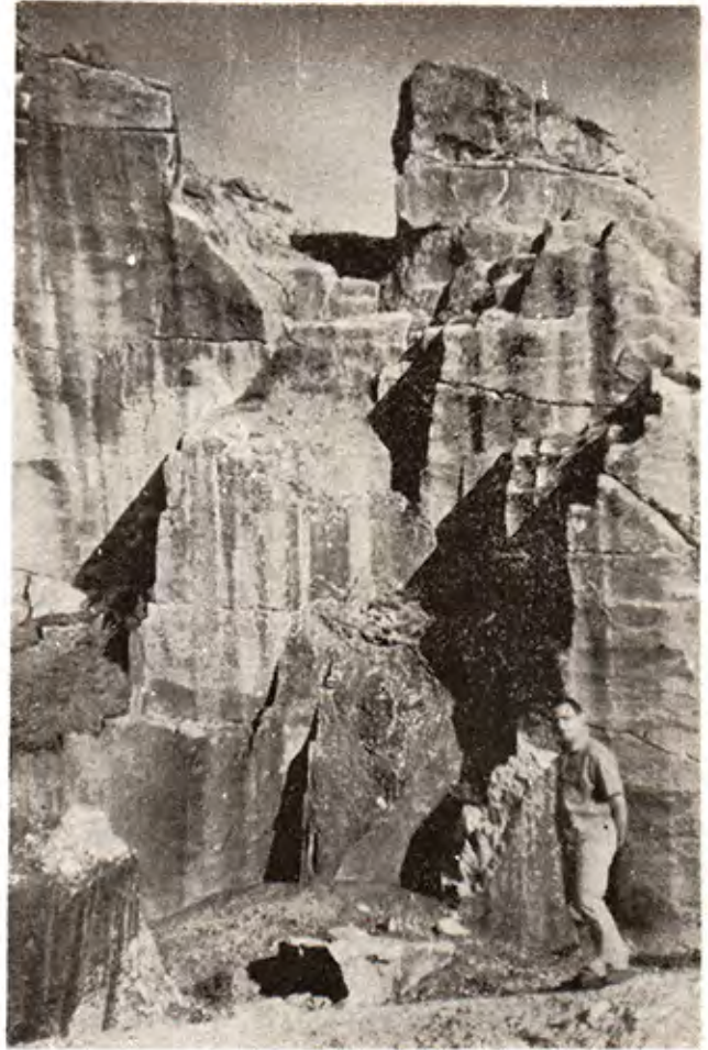
Şekil 12 — Kütahya-Yoncalı-Enne arası testere ile çalıştırılan kalker ocağı (Roma, K. Erguvanlı, 1967).
