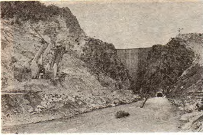
Foto 4—Baraj ve dolu savak yapımının mansaptan görünüşü, (M. Çetinçelik, 1983).
