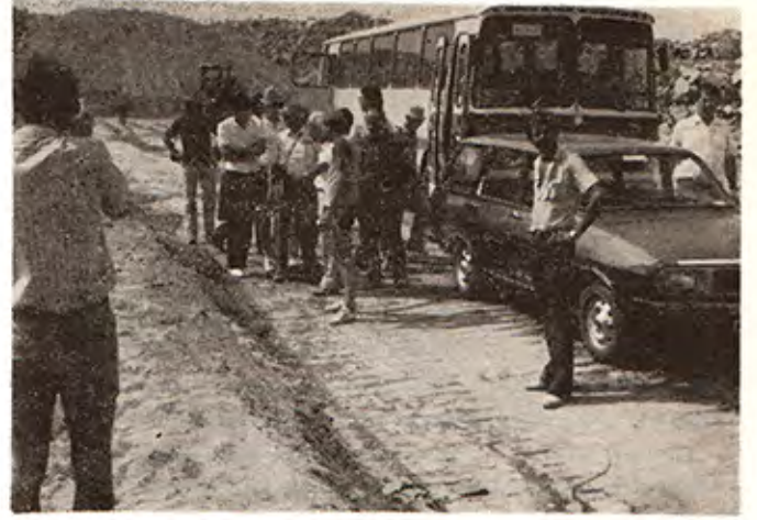
Foto 4 — Kırklareli-Kayalidere barajı gövde yapımı.
