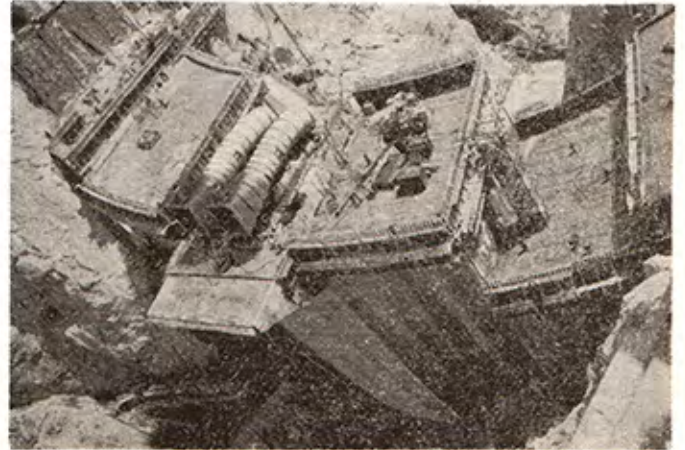
Foto 1 — Oymapınar barajı üzerinde dip savakların yapımı, (D.S.İ. 1981).
