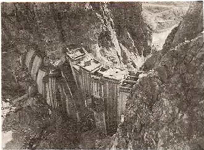
Foto 2 — Paleozoyik kireçtaşları üzerinde beton kemer tipindeki Oymapınar barajının yapımı, (D.S.İ. 1982).
