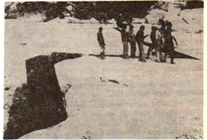
Şekil 2 ve 3 — Fransada, bir granit ocağında 800 ton ağırlığındaki bloğun, yumuşak patlatma ile elde edilmesi (Beturné, 1982).
