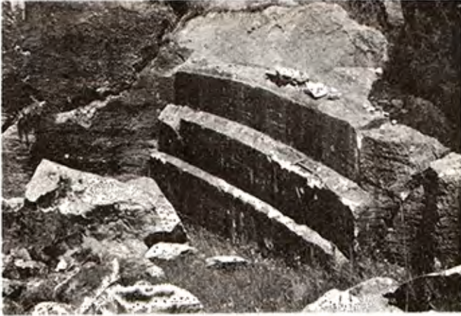
Şekil 3 — Afyon tel testere ocaklarından biri (1970, Yüzer).
